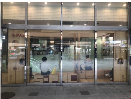
エスパル本館 1階「CLT フレーム&ベンチ」
